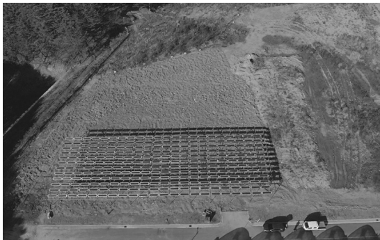
영농형태양광 설치 전경
