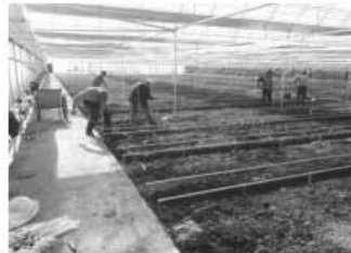
하우스 내 베드 설치
