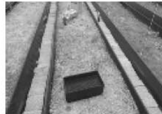
베드 바닥 배수로 설치
