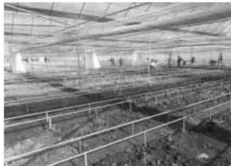
연동하우스 기초 공사
