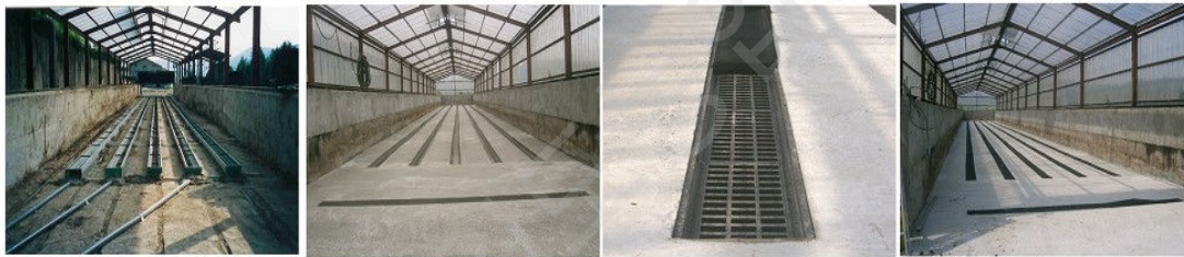
(송풍라인 및 바닥 피트 설치)
