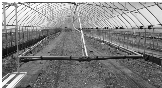
저상스프링클러 설치 전경
