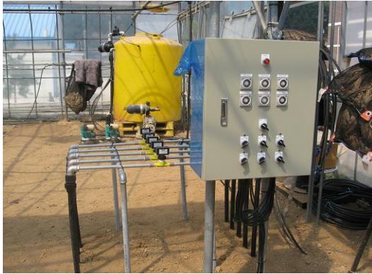
<그림 1-6> 자동관수시스템 설치
